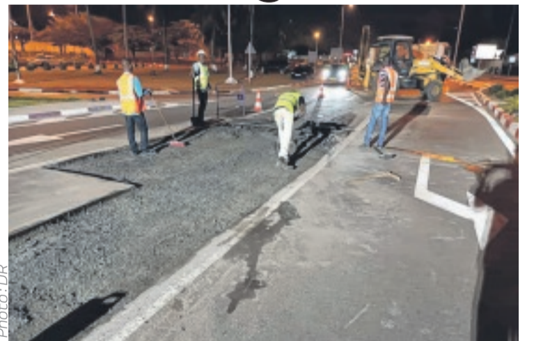
Une vue des travaux menés en pleine nuit.
